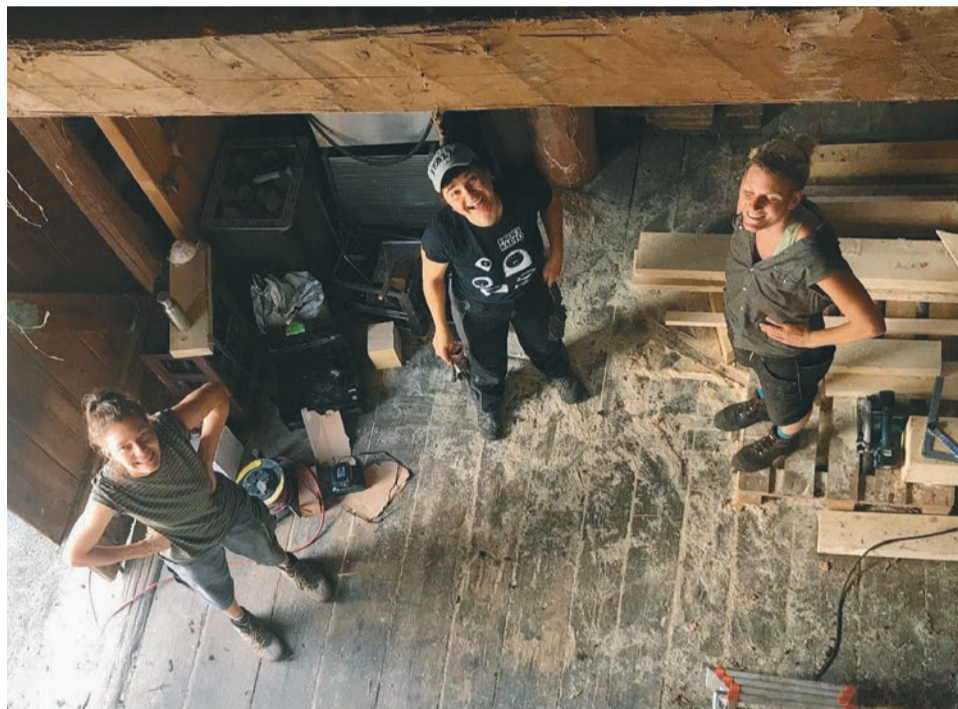
Mit der Dachbaustelle sorgt das GemSe-Kollektiv für kommende Winter vor.
