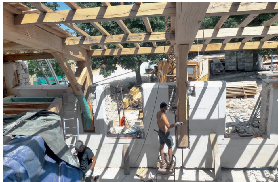
Der Gemeinschaftssaal von Grange Neuve wird von Grund auf renoviert.
